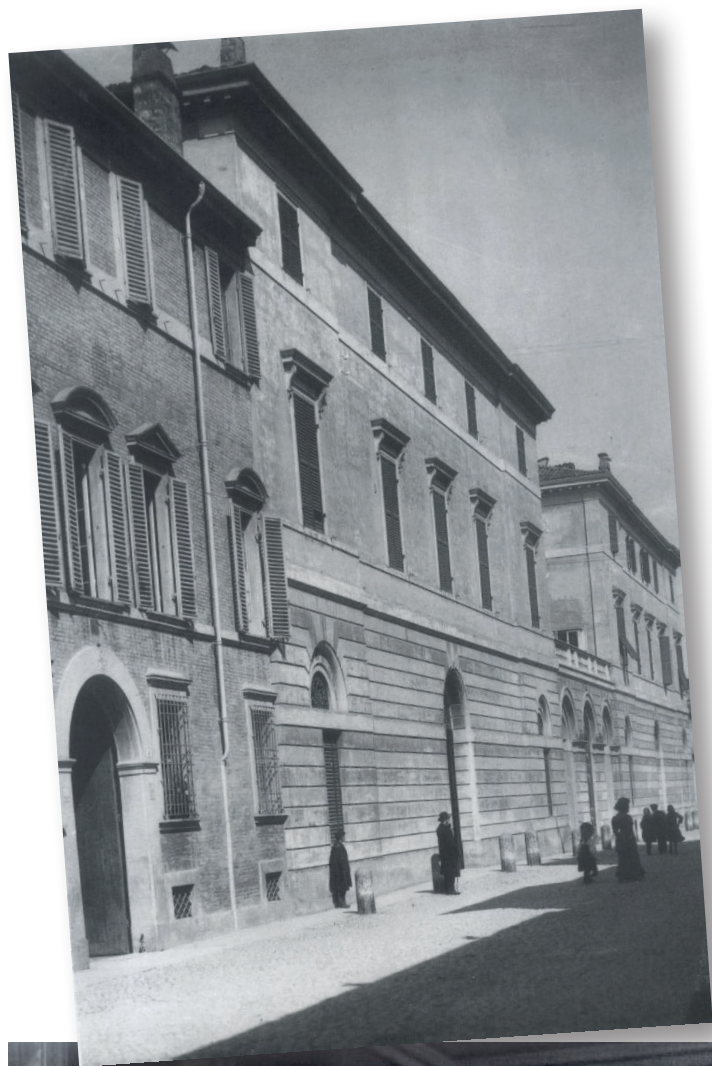
Palazzo Campori, facciata, intorno 1908
